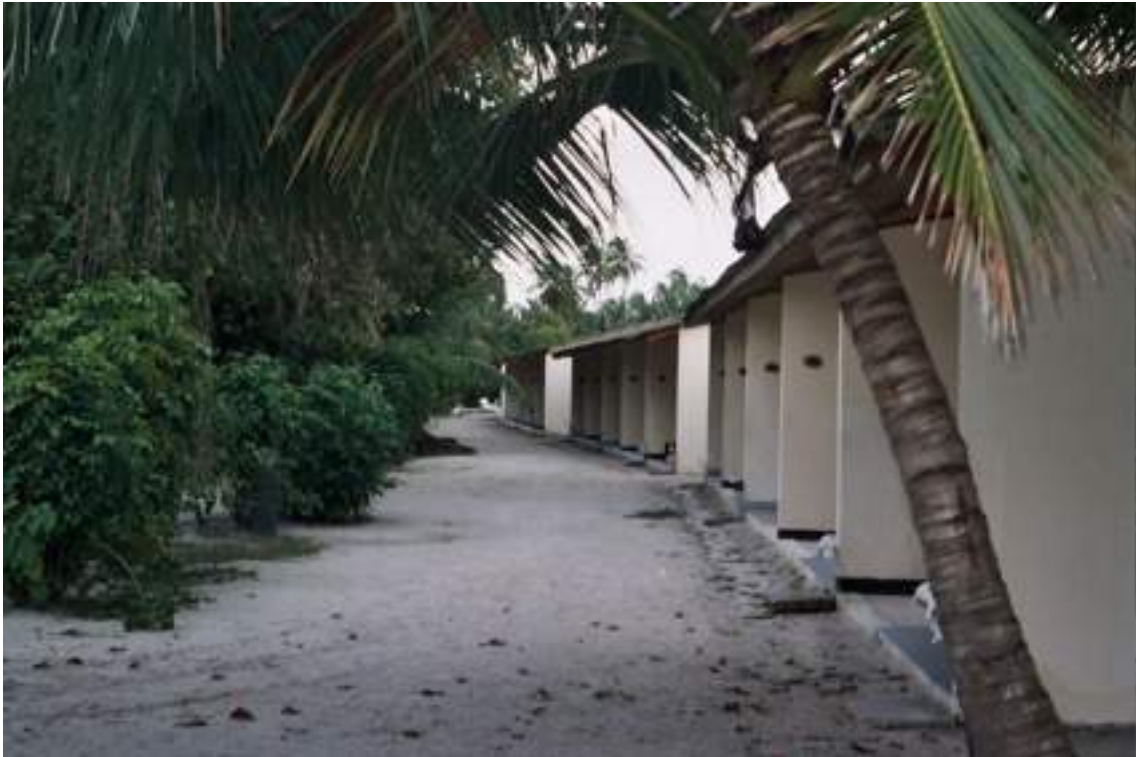
Afbeelding 2: Betonnen blokkendozen op de Malediven
